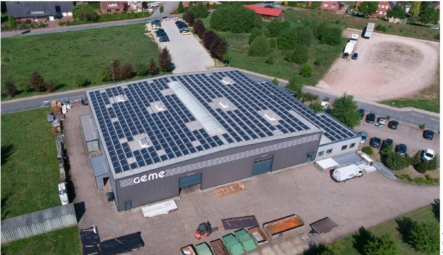
Diesen Solargenerator (135 Kilowatt) hat Köster Energie mit einem Senec-Gewerbespeicher (30 Kilowattstunden) in Hagen gebaut.
